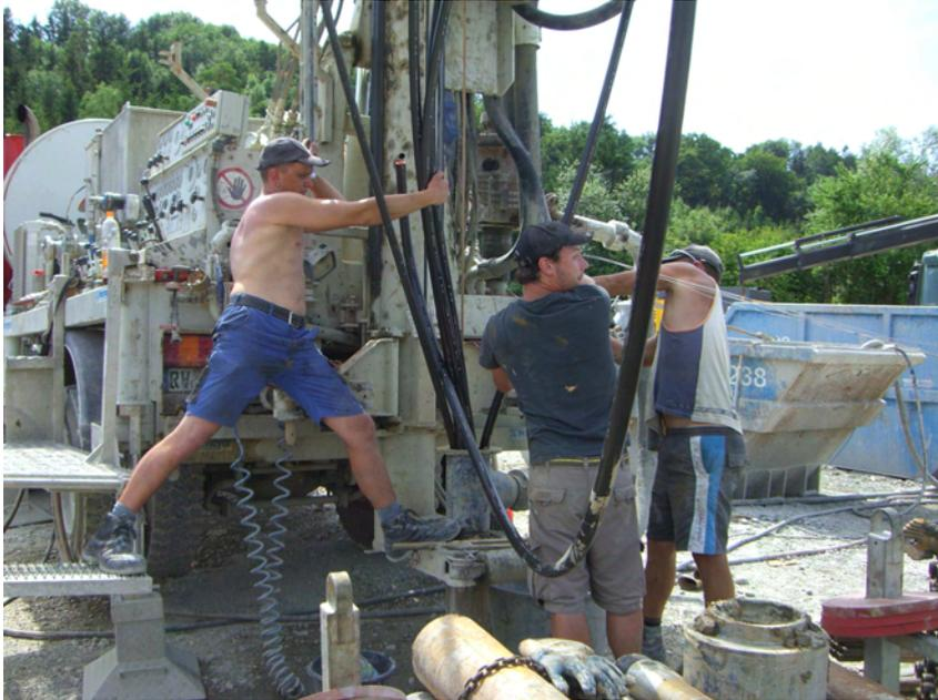
Abbildung 3: Einbringung Sonde
