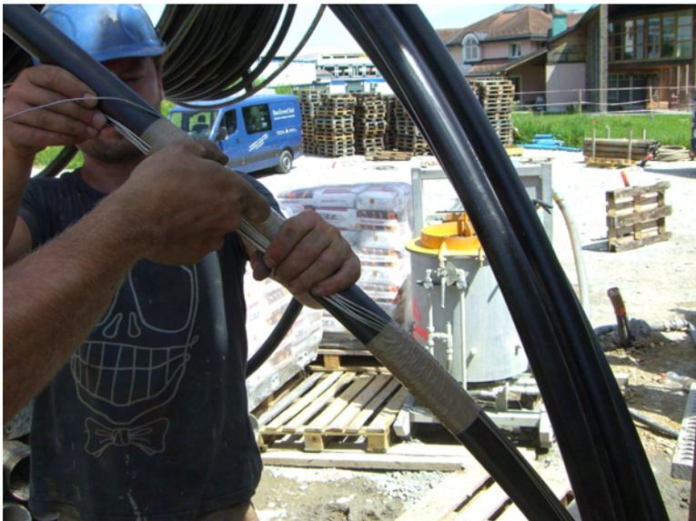
Abbildung 2: Fixierung Mantelthermoelemente
